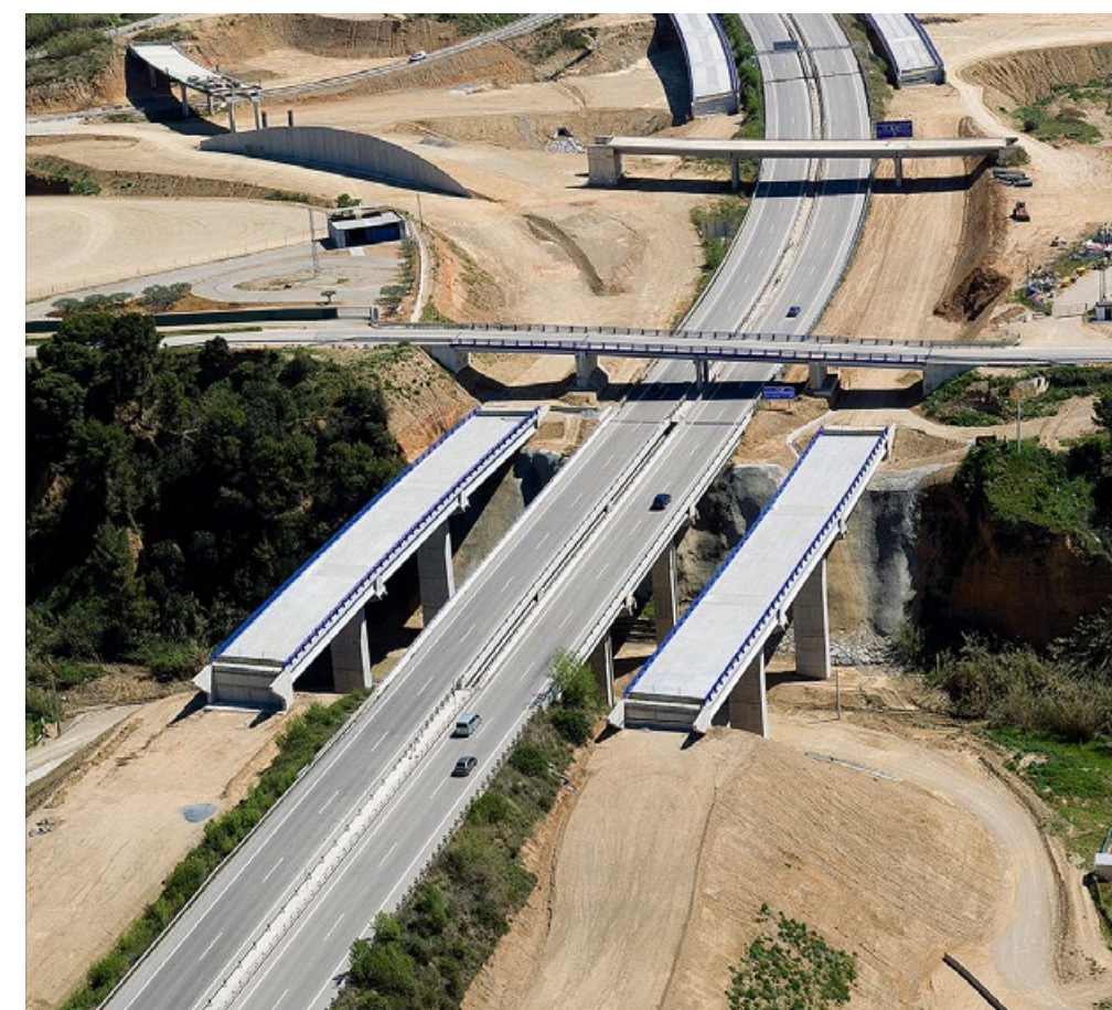
Autovía B-40. Tramo Olesa de Montserrat-Viladecavalls (España)
