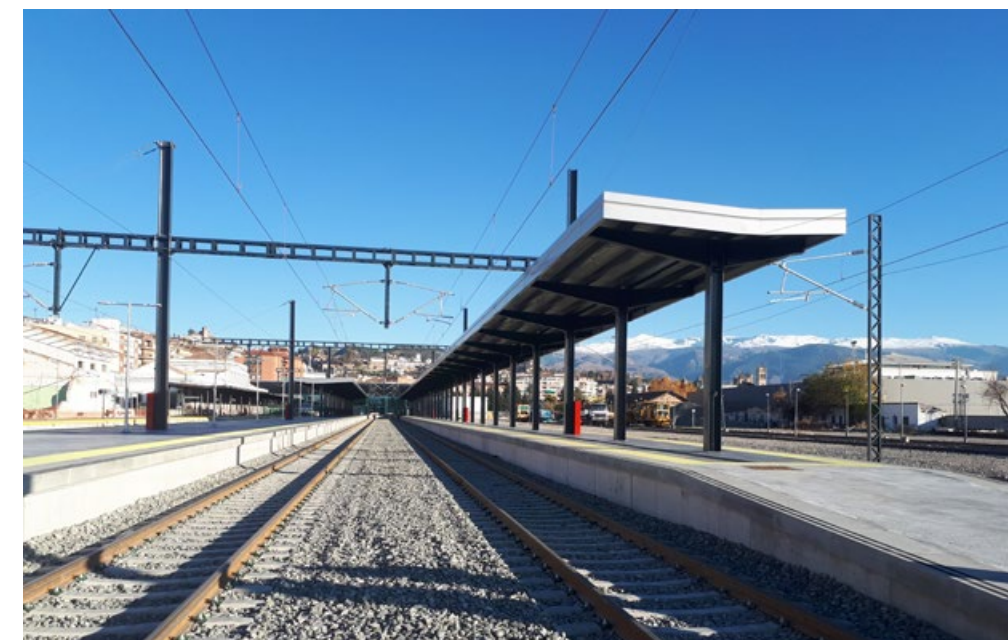
Construcción de la línea de Alta Velocidad Antequera - Granada: tramos Tocón - Granada y accesos a Granada (España)
