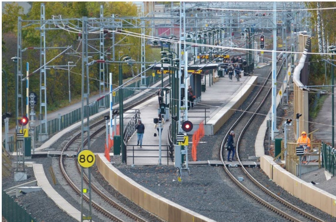
Desdoblamiento de vía entre las estaciones de Tibble y Visinge en Täby (Suecia)
