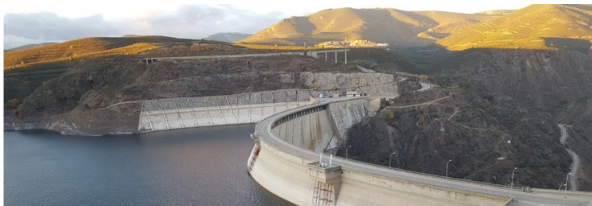
Mantenimiento correctivo y actuaciones en las instalaciones del Departamento de Presas del Canal de Isabel II, Madrid (España)
