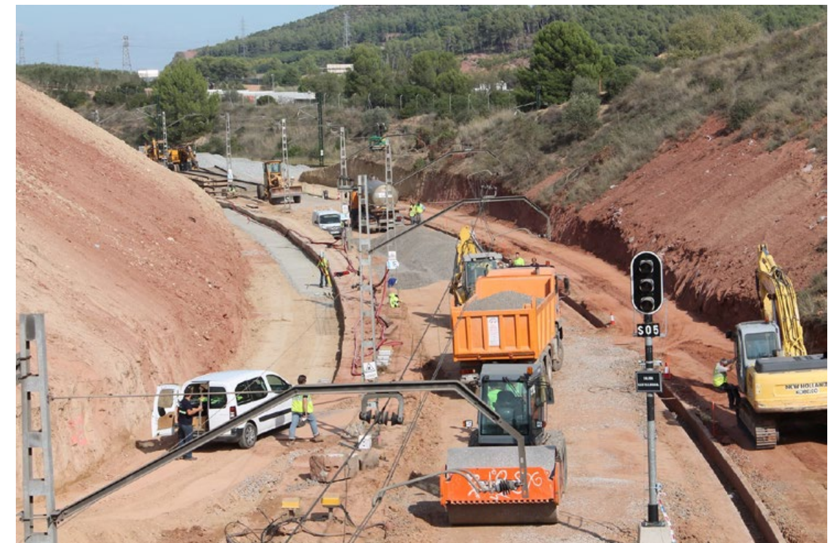
Aplicación de árido siderúrgico en capas de subbalasto y de forma como parte del proyecto GAIN en Castellbisbal (España)
