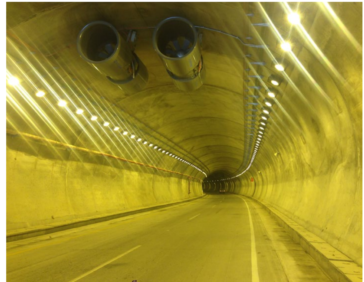
Suministro eléctrico y alumbrado de túneles de la autovía México - Tuxpan (México)
